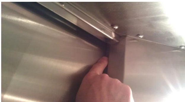
34) Check door seal / Vérifiez tous les joints / Revise el sello de puerta
