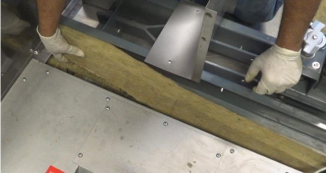
9) Insulate the top / Isoler le haut / Aislar la parte superior
