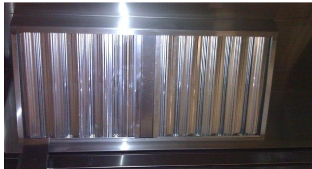
49) Install Filters & Spacers /Installer des filtres et des entretoises /Instale los filtros y separadores
