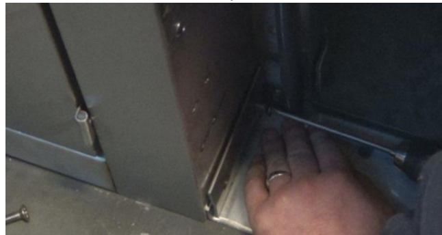
24) Clamp threshold / Clamp seuil / Sujete umbral
