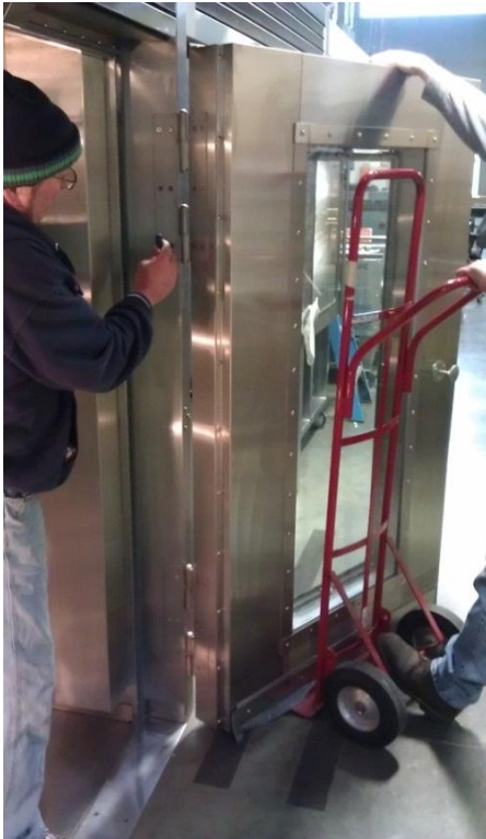
31) Install the door, check the gap / Installez la porte, vérifiez l'écart / Instale la puerta, compruebe la brecha
