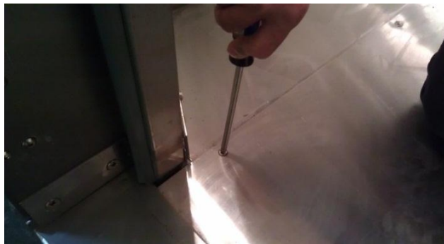
21) Join floor sections / Joindre les sections de plancher / Únete secciones de suelo
