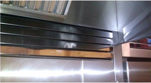
50) Install Louvers / Installez ouïes / Instale rejillas
