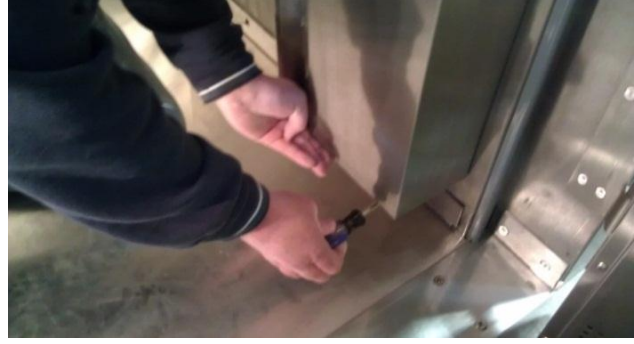
28) Install front duct / Installez conduit avant / Instalar el conducto frontal
