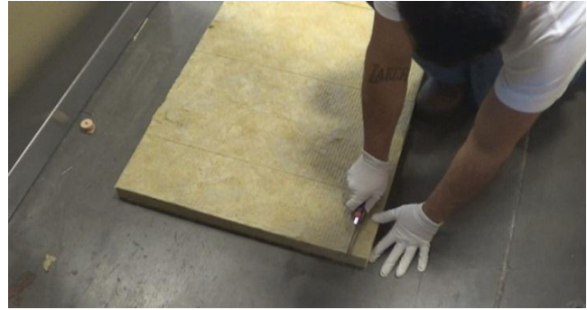
10) Insulate the rear / Isoler l'arrière / Aislar la parte posterior
